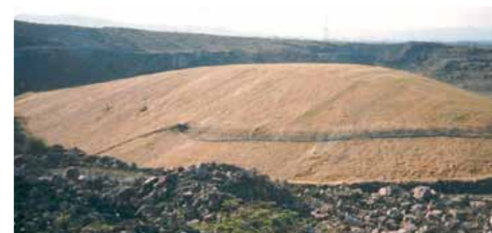
Covamat plus danga laikinai padengtas sąvartynas, siekiant apsaugoti nuo erozijos.
