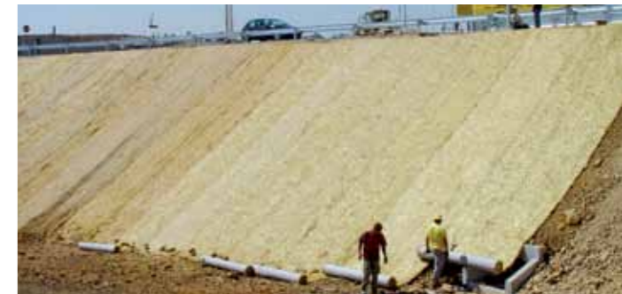
Autostrados šlaitų apsauga naudojant Covamat plus dangą Lisabonoje/ Portugalijoje
