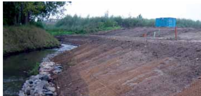
GREENFIX Embankment Mat Type 400S panaudojimas
