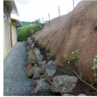
Sėkmingai instaliuota GREENFIX Rockmat Type 6D danga Naujojoje Kaledonijoje
