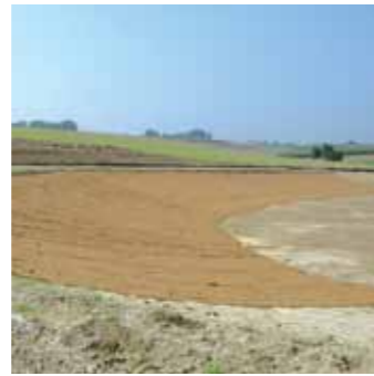
GREENFIX Eromat naudojimas vandeniui sulaikyti (instaliavimo metu)
