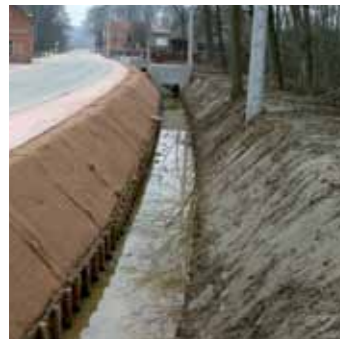
Šlaitų apsauga išilgai drenazinio kanalo panaudojant GREENFIX Eromat dangą
