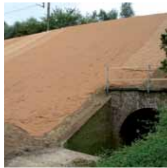
Staus geležinkelio šlaito apsauga su GREENFIX Eromat
